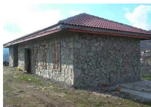
El refugio construido
